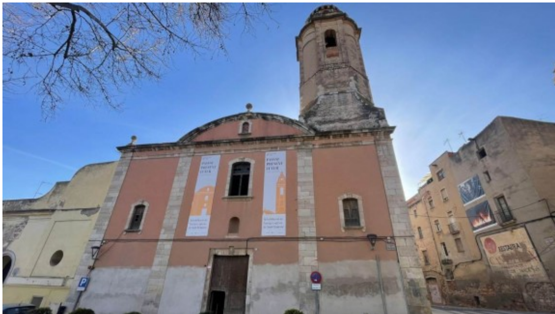
Imatge de l'exterior de l'església Foto: Albert Oliva
